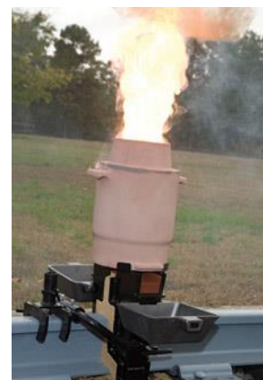
Figura 1 - Soldagem aluminotérmica [4]
