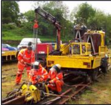
Figura 3 - Soldagem a gás [4]
